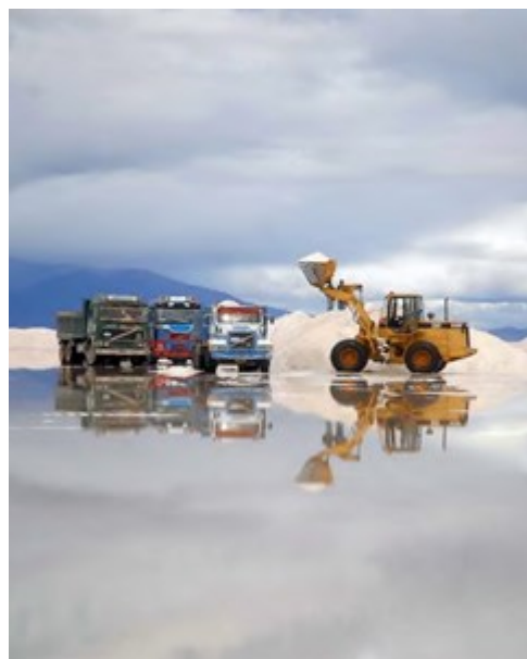
Trabajos de construcción de diques para piscinas de evaporación. Gerencia Nacional de Recursos Evaporíticos, 2010.
